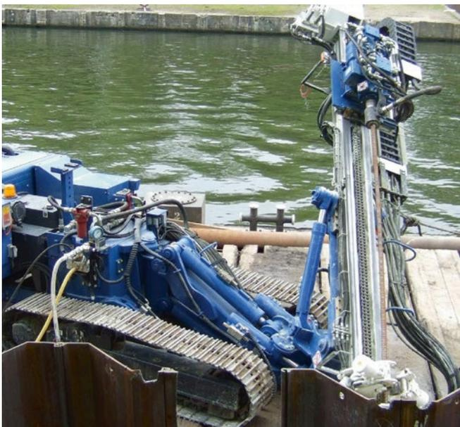
HB20: Gewindestangen-Bohrung Ø52 mm (2 Zoll)
